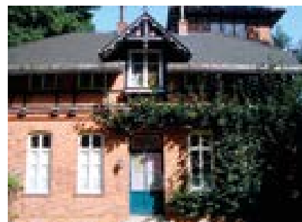
Östliches Torhaus der Albrechtsburg mit dahinter liegendem Wasserturm.
