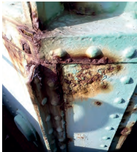
Roststellen im Außenbereich der Stahlkanzel
